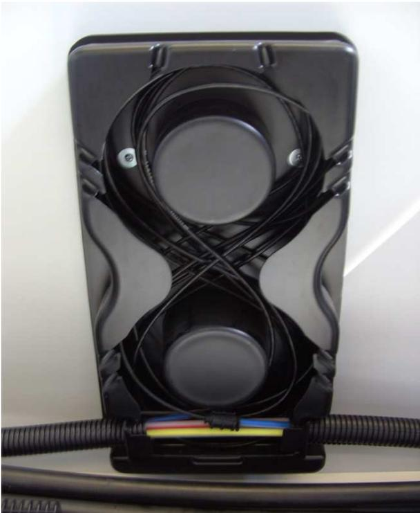
2) Die Micro-Kabel-Überlänge der belegten speedpipe in der C-Box ablegen.
